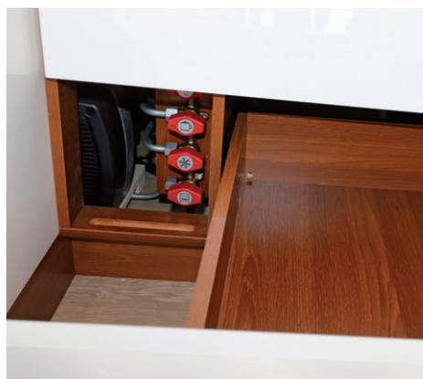
In der unteren Schublade sind die gut erreichbaren Gasabsperrhähne installiert.
